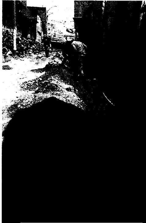
COMPACTACIÓN POR CAPAS DE ZANJAS EN TRABAJOS DE MEDIA TENSION
